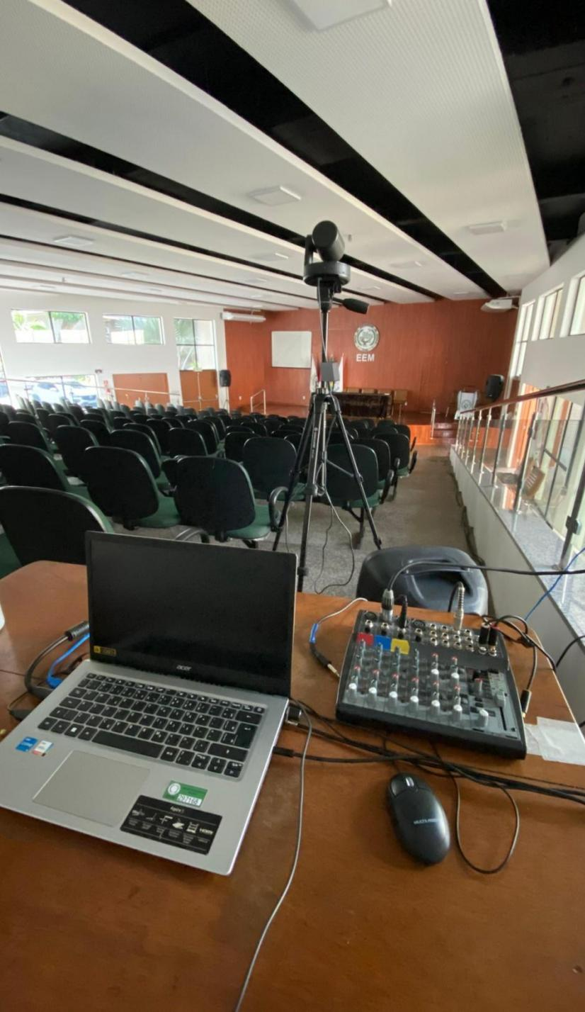
O auditório possui sistema audiovisual composto por um projetor, uma tela de projeção fixada a parede de fundo do palco, um púlpito de vidro, dois microfones sem fio, mesa de quatro canais, quatro caixas de som de 115 watts, notebook e câmera de captação de imagens
