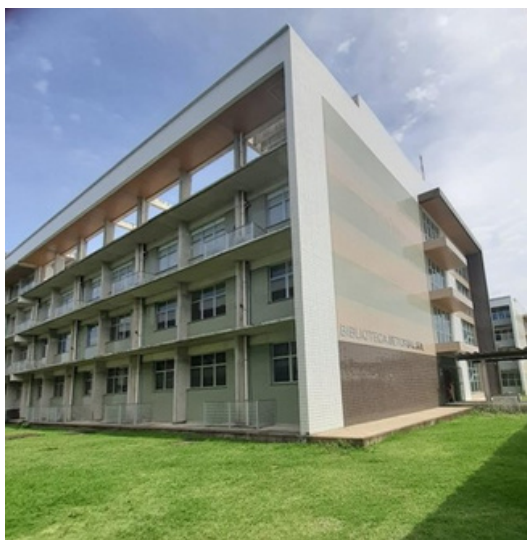
Figura 1 – Biblioteca Setorial Sul – Campus UFAM
